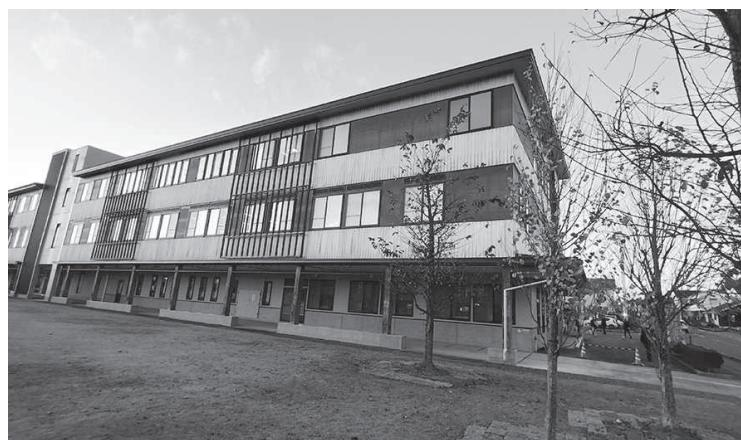
施設の概要は木造3階建てと鉄筋コンクリート造4階建ての複合構造で、延床面積6650平方メートル、事業費は33億8000万円、事業の手法はPFI（プライベート・ファイナンス・イニシアティブ）のBTTO方式（民間事業者が設計・建設し、施設完成直後に町に所有権を移転し、その後、民間事業者が15年間維持管理を行う。）により建設されました。
