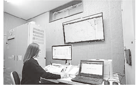
役場庁舎内の防災無線室
