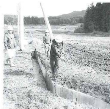
吹きつけ作業
