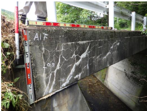
写真 1.3 床版ひび割れ
