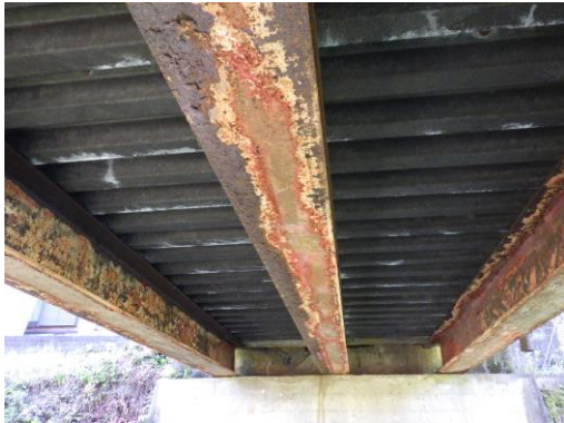
写真 1.1 主桁塗装劣化
