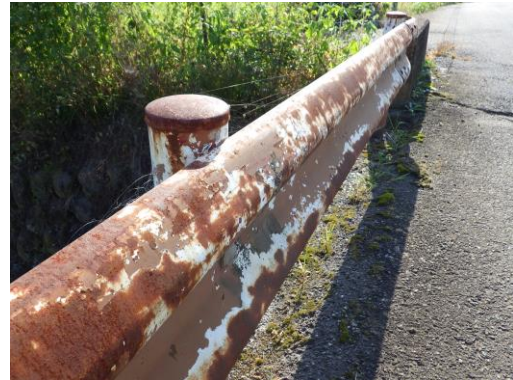
写真 1.2 ガードレール塗装劣化
