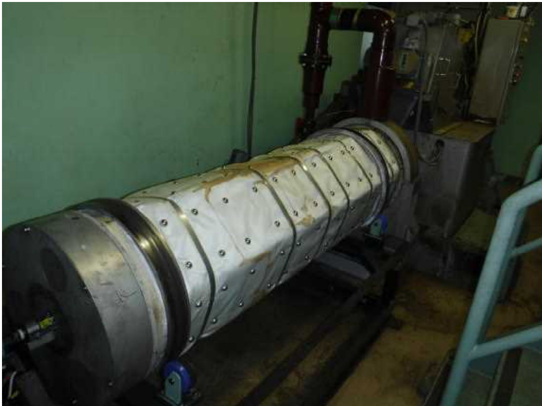
原・本宿・新田地区汚泥乾燥機修繕
