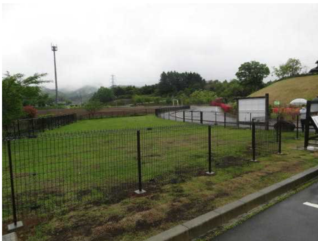
道の駅中山盆地ドッグラン整備工事
