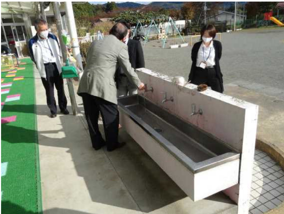
幼稚園小学校中学校水栓交換工事（幼稚園）
