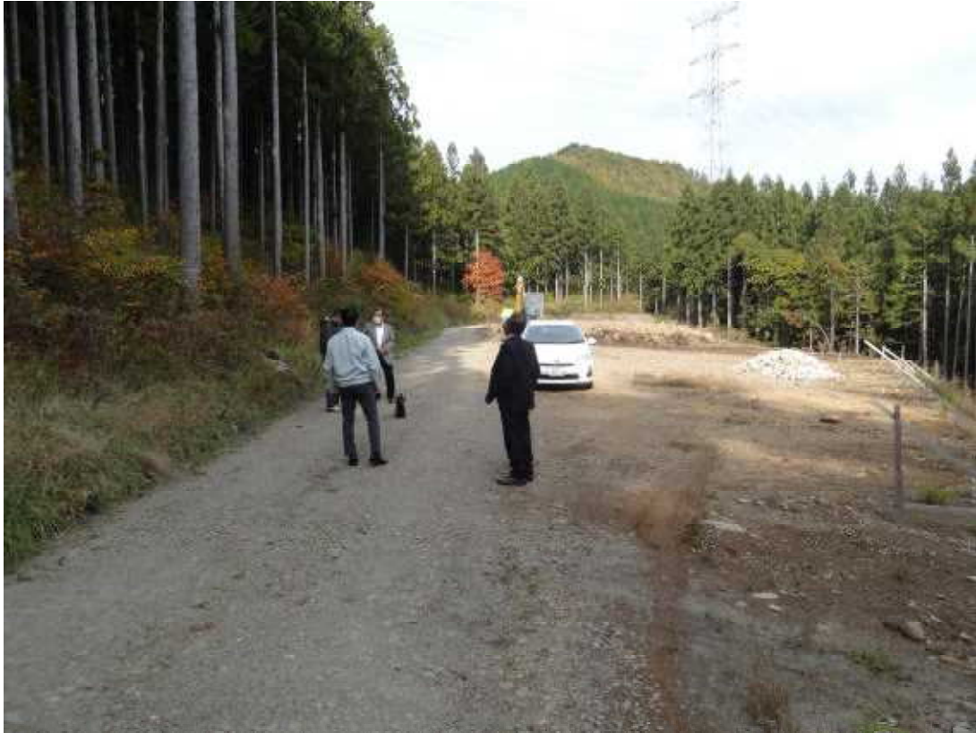
基幹作業道切ヶ久保第5北山線新設工事
