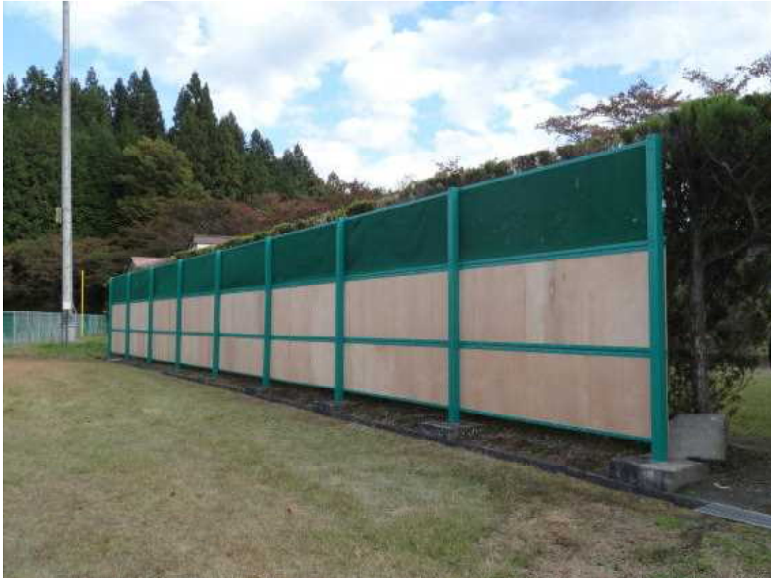
高山弓道場防矢ネット修繕事業
