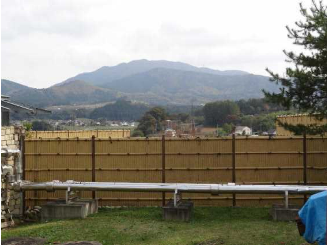
ふれあいプラザ温泉目隠フェンス設置工事
