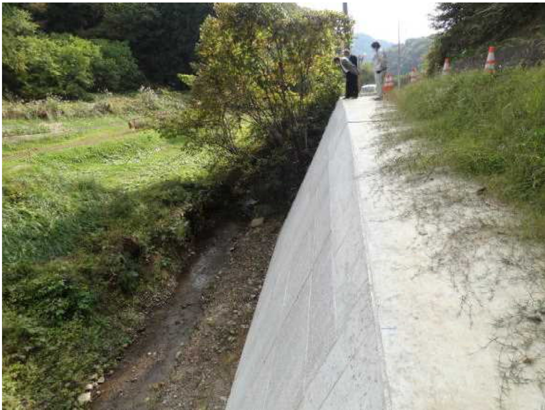
村道権現線道路復旧工事
