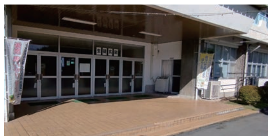
改修した小学校玄関（写真左）と中学校玄関
