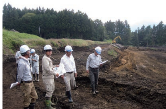
農地整備中の工事の様子
