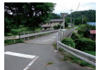
向井橋（完成後）
