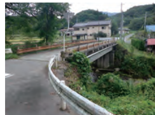
向井橋（着工前）
