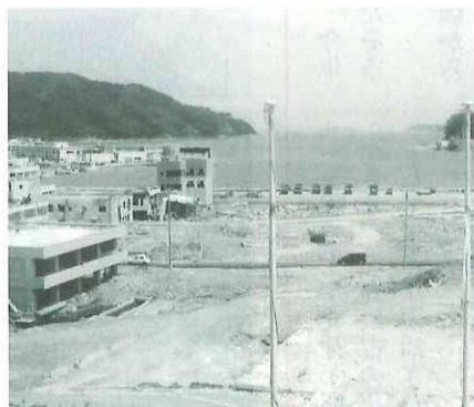
がれきが片付けられた女川港
