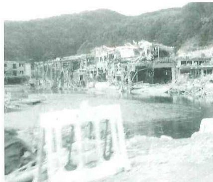
津波にのみこまれた魚の加工場
